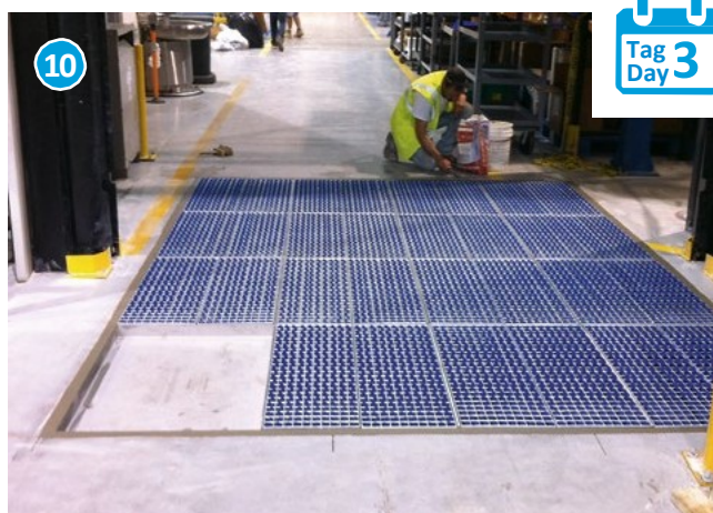
10 Установить решетки ProfilGate® в поддоны.
